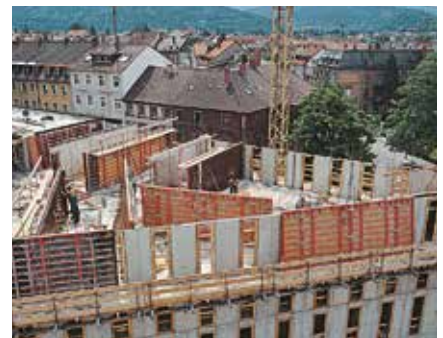
TRIO는 표준 TRIO 판넬과 결합할 수 있습니다. 이는 특수 표면이 한 면에만 필요한 경우가 많기 때문에 큰 장점입니다.
