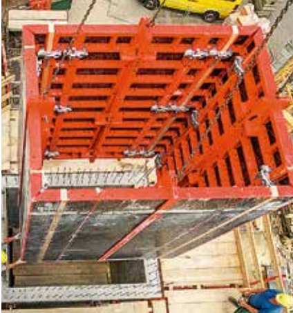
부착 지점의 길이가 다르기 때문에 직사각형의 샤프트에는 조절 가능한 크레인 슬링이 필요합니다. 이는 모든 4개의 슬링에 대해 거의 동일한 인장력을 발생시킵니다.
