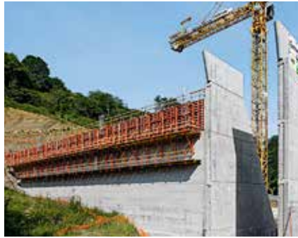
Lurberria Dam, St Pée Sur Nivelles, France
