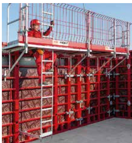
MXK 브라켓 시스템의 표준 어셈블리는 2.40m, 1.20m 또는 0.90m의 폭으로 구현됩니다.
