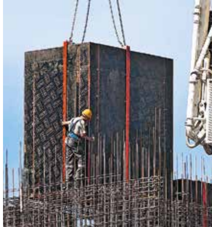
샤프트 패널을 들어 올릴 때, 각 면마다 3cm의 탈형 간격이 제공되고, 하나의 크레인 리프트로 전체 장치를 이동시킬 수 있습니다.
