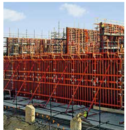
TRIO는 30cm 단위로 5.40 m 높이까지 연장 가능합니다. 높이가 더 높은 경우, 컴펜세이션 웨일러도 사용됩니다.
