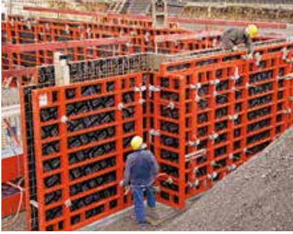
주거용 건물 Neuperlach, Munich, Germany
