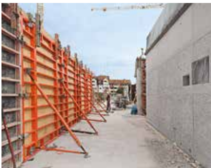
TRIO는 입증된 판넬 거푸집 시스템의 변형으로, 다양한 TRIO 부품들과 함께 사용될 수 있습니다.
