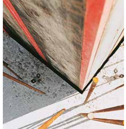
약 3cm 폭의 탈형 간격이 선명하게 보입니다. 샤프트 패널 자체는 콘크리트에 가깝게 유지되므로 더 나은 시공성을 보여줍니다.
