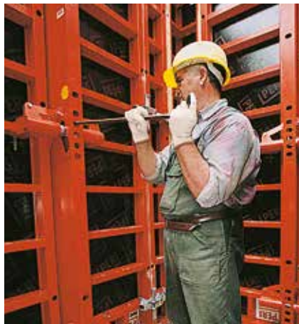
탈형 시, 크레인 슬링은 4개의 샤프트 패널에 모두 부착되고 거푸집 패널은 레버링(levering)에 의하여 탈형 위치로 이동됩니다.
