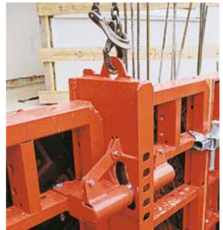
크레인으로 들어 올려진 경우, 샤프트 패널 TSE가 해체되어 필요한 탈형 간극이 발생하게 됩니다.
